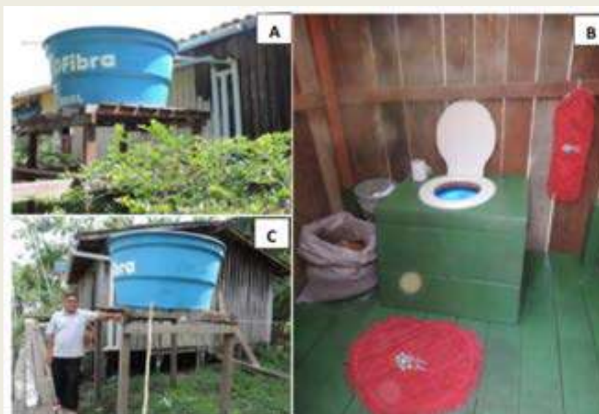
Figura 4 – Sistemas de captação e armazenamento da água da chuva adaptadas (A) e (C); Banheiro Ecológico Ribeirinho depois da implantação (B).
